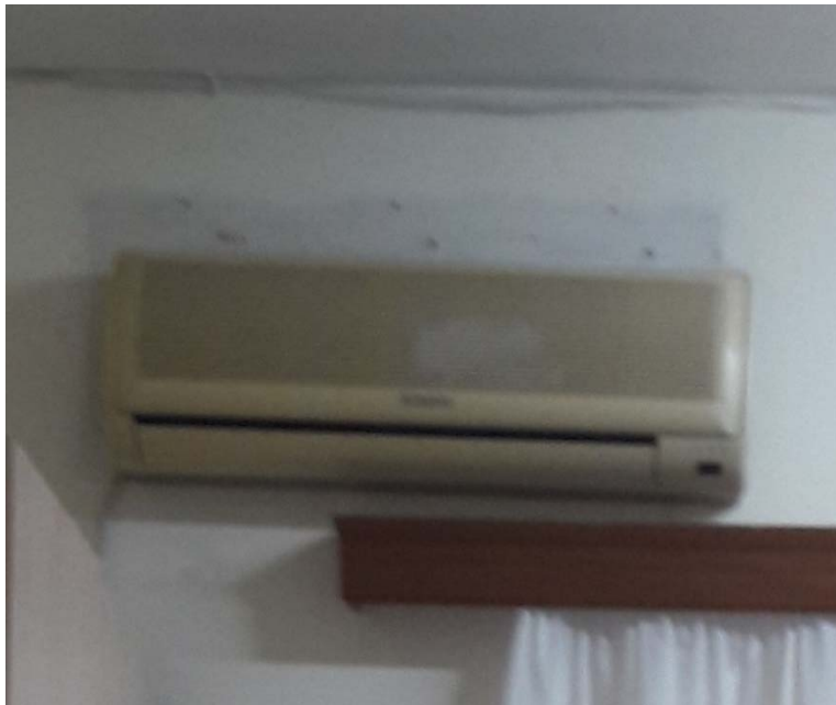
Εικόνα 8: Τοπική Αντλία θερμότητας αέρα-αέρα για ψύξη
