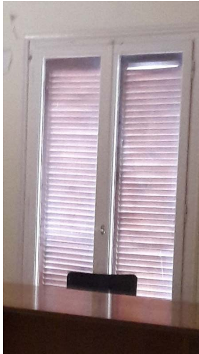
Εικόνα 3: Εξωτερικά Κουφώματα από ξύλινο πλαίσιο.
