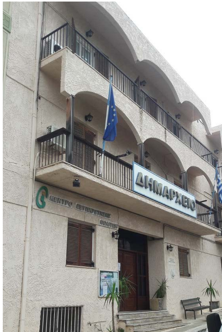
Εικόνα 1: Βόρειο-Ανατολική όψη κτιρίου - -κεντρική είσοδος
