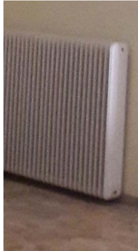
Εικόνα 6: Τερματική μονάδα-καλοριφέρ σε γραφείο
