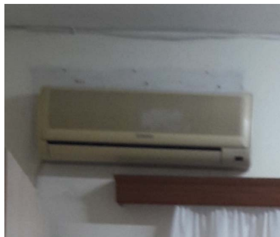
Εικόνα 7: Τοπική Αντλία θερμότητας αέρα-αέρα για θέρμανση
